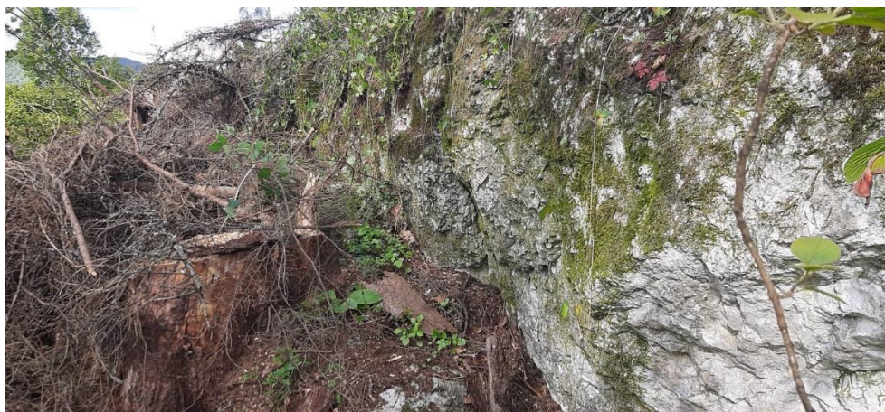
Slika 10. Klesana stijena u podgrađu – mogući dio vanjskog prstena ili zida objekta
