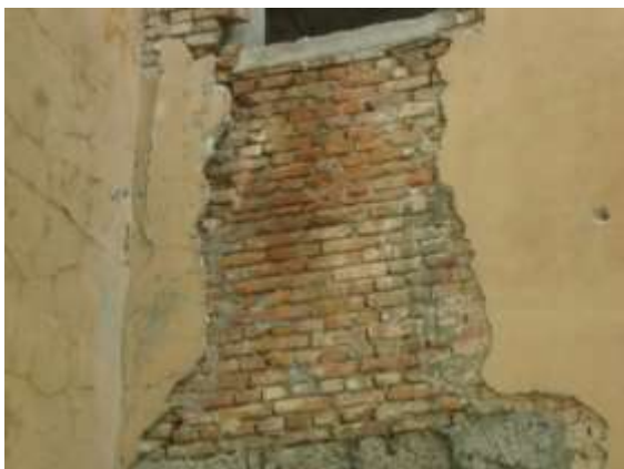
Slika 1. Detalj zidova građenih punom opekom (objekat Stare pošte)
