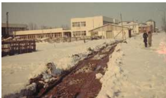
Sl.9 Komplex Doma zdravlja u izgradnji
